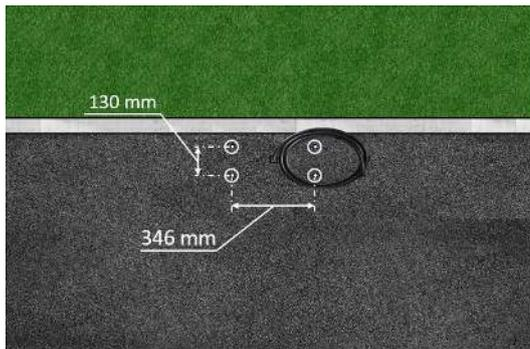
1. Bohrlöcher gemäß Zeichnung mit geeignetem Bohrwerkzeug einbringen.
